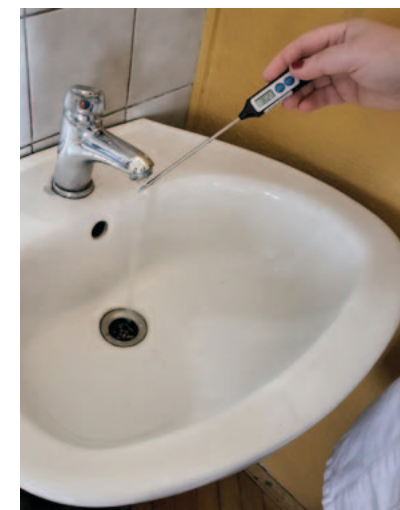
Neadekvatna temperatura potrošne tople vode
